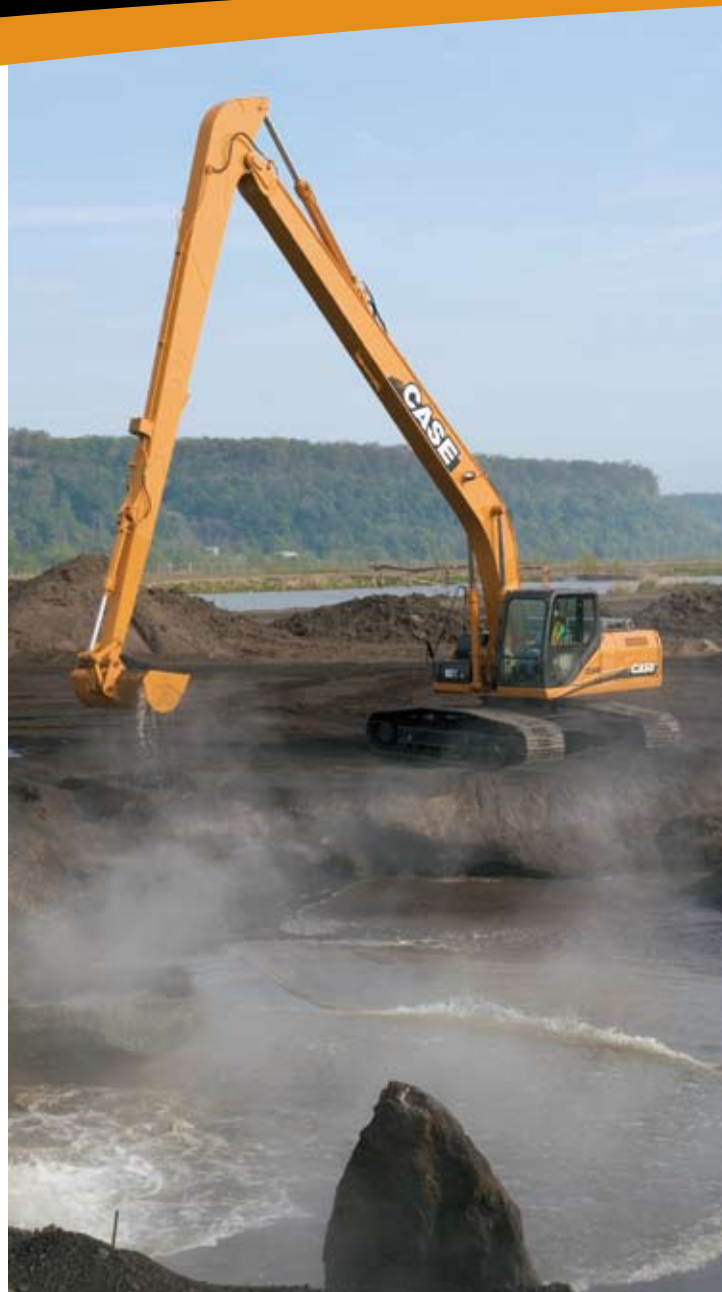
Excavación de Zanjas
